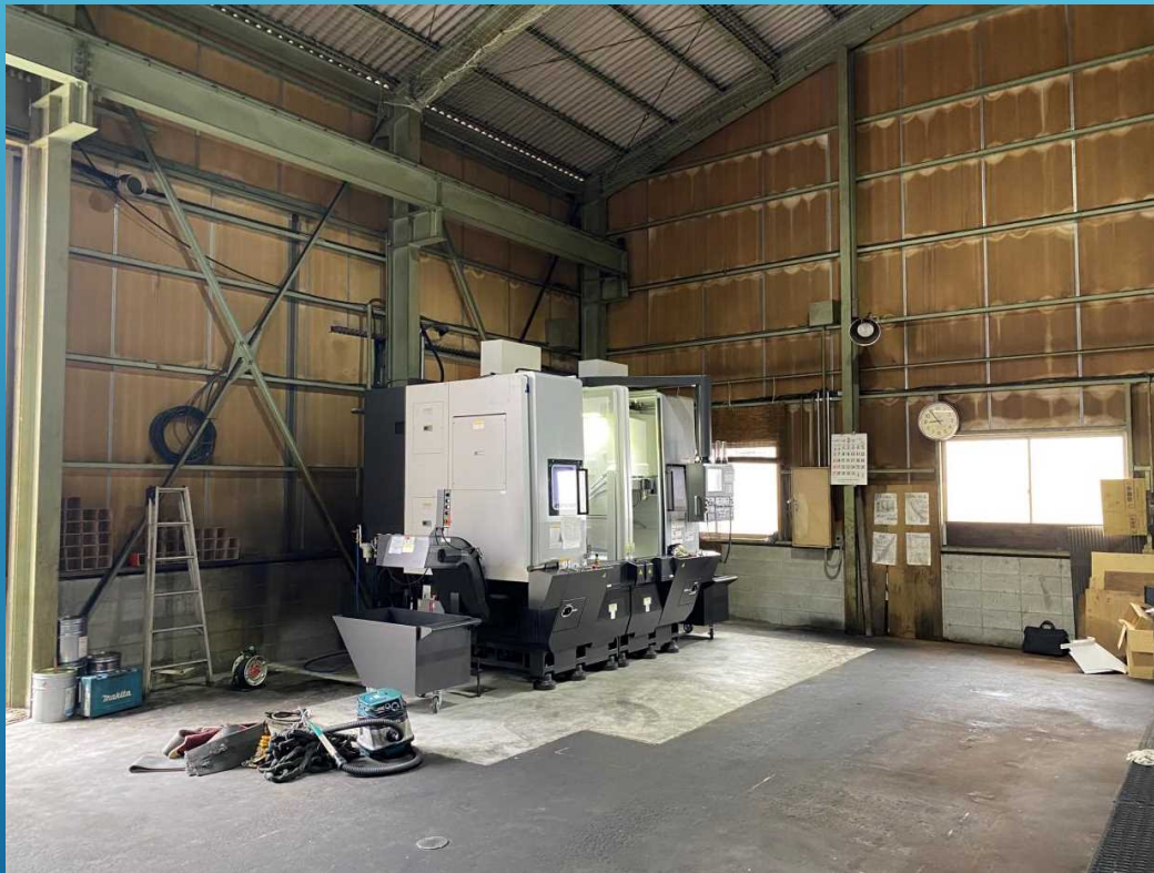
現地搬入前状況
